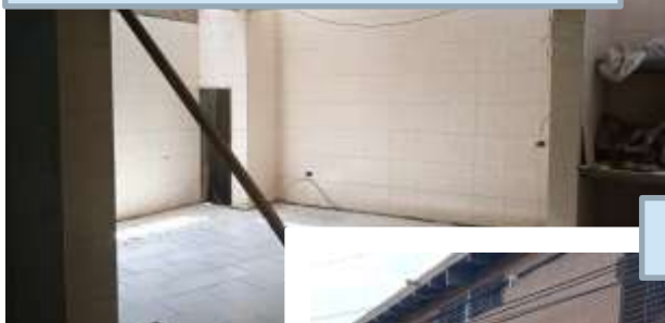
Cocina para los servicios comunitarios
